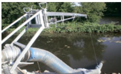
После заливки бетонного основания переходим к изготовлению напорной гарнитуры для насосной станции. Важными ее элементами являются: виброкомпенсатор, обратный клапан, расходомер, задвижка. Вокруг обратного клапана делаем байпас - для того чтобы заполнять водозаборную гарнитуру.
