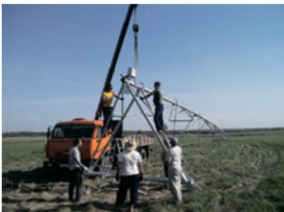
Параллельно отправляем собранную центральную башню в поле, где производим ее монтаж на уже готовое, залитое под нее, бетонное основание.
