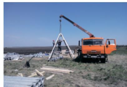
Другое занимается сборкой пролетов установки. Размещаем на площадке все трубы (которые требуются для сборки одной установки) попролетно. Далее начинаем сборку на земле, то есть производим все те работы, которые
