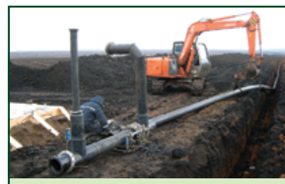
Укладка пластикового трубопровода в траншею и обратная засыпка грунтом.
