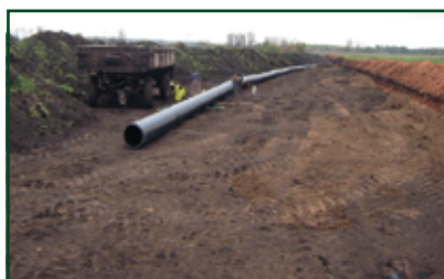
На свободном участке между траншеей и снятым слоем плодородной почвы бригада специалистов приступает к пайке пластикового трубопровода.
