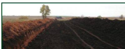
Параллельно с обустройством места водозабора ведутся работы по рытью траншей под трубопровод со снятием плодородного горизонта почвы. Ведение операции также контролирует топограф.
