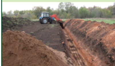
На дне траншеи делается песчаная подушка.
