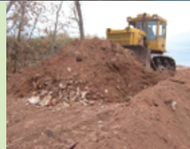
Ведение планировки основания под насосную станцию. Выравнивание площадки.
