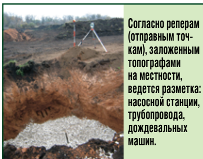
Первый этап строительства: обустройство основания под насосную станцию. Отсыпка щебнем и грунтом.
