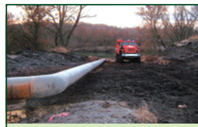
По итогам всех монтажных работ была произведена опрессовка пластикового трубопровода. На этом завершилась осенняя часть работ по строительству системы орошения.
