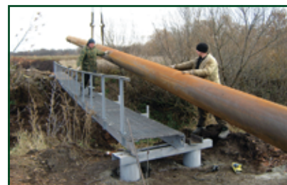
От насосной станции трубопровод прокладывался по надземной части, в связи с тем, что пришлось преодолевать овраг. Для этого проектом было утверждено использование моста из металлического профиля. Пластиковая труба разрушается от ультрафиолетовых лучей, поэтому вместо нее была использована стальная.
