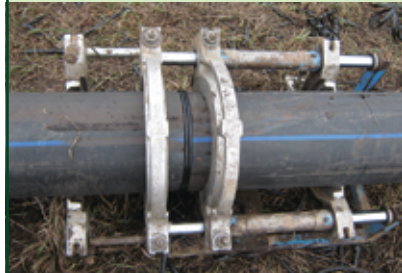
На свободном участке между траншеей и снятым слоем плодородной почвы бригада специалистов приступает к пайке пластикового трубопровода.
