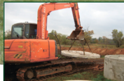
Также проектом был предусмотрен монтаж опорных колодцев.
